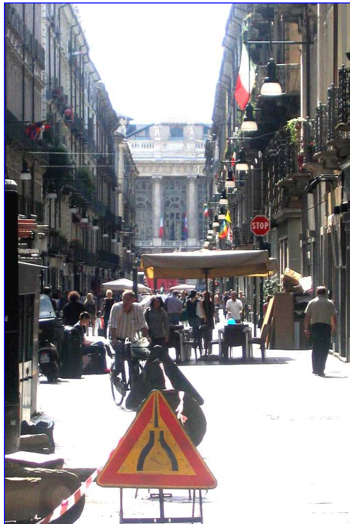
Street Art – segnaletica lavori in via Garibaldi
